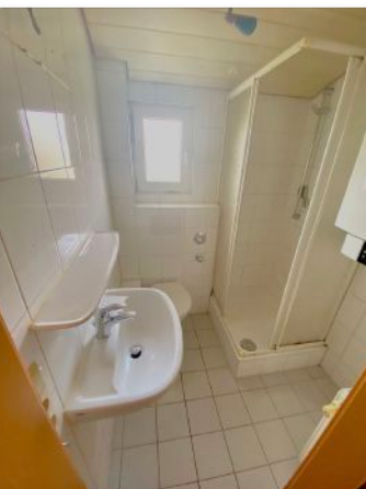
WOHNUNG NR. 5 (DG), BAD
